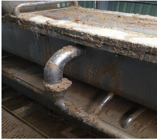
รูปที่ 5 ท่อระบายน้ำที่อยู่ด้านข้าง
