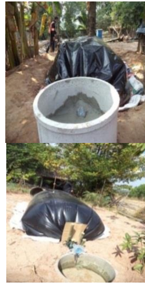
รูปที่ 8 ทำบ่อล้นและบ่อเติม
