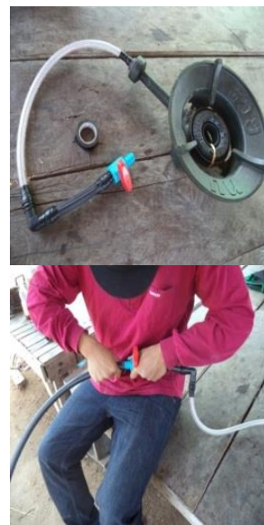
รูปที่ 10 ติดตั้งท่อส่งก๊าซและวาล์วควบคุมก๊าซ
