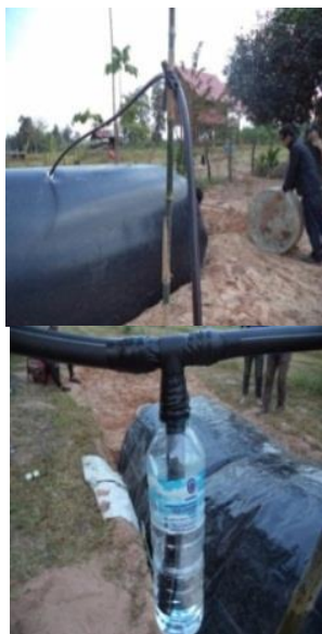
รูปที่ 9 ประกอบสายส่งก๊าซและขวดปรับแรงดัน
